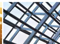
STRUTTURE IN ACCIAIO
