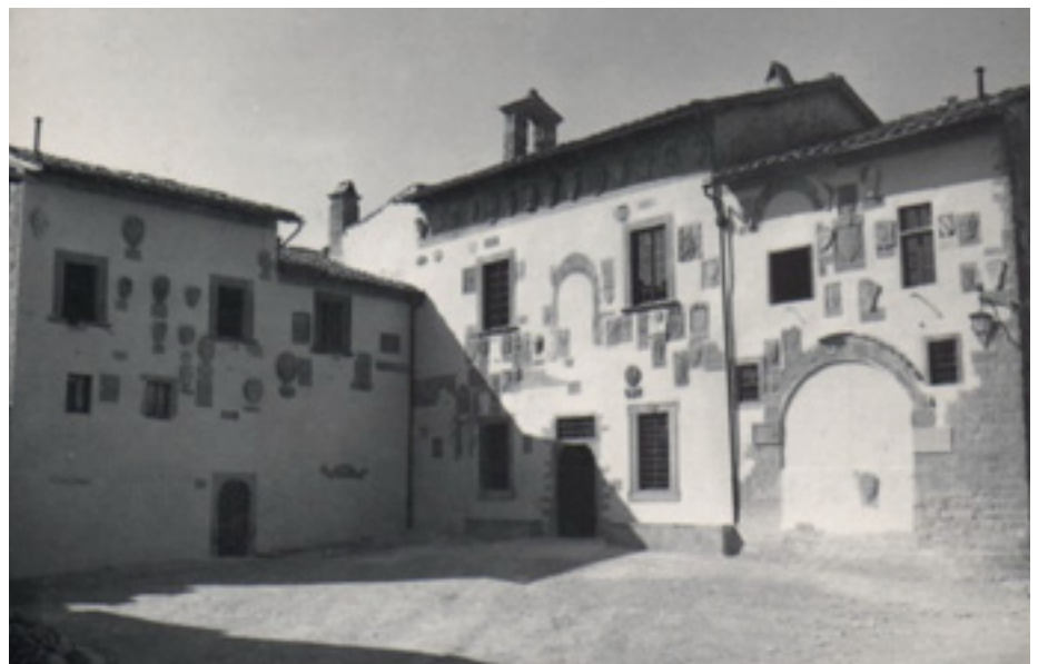
Palazzo Pretorio, sede comunale di Anghiari che attende il ritorno degli uffici dell'amministrazione
