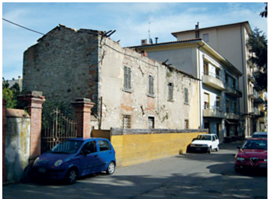
L'edificio in stato fatiscante lungo viale Armando Diaz a Sansepolcro
