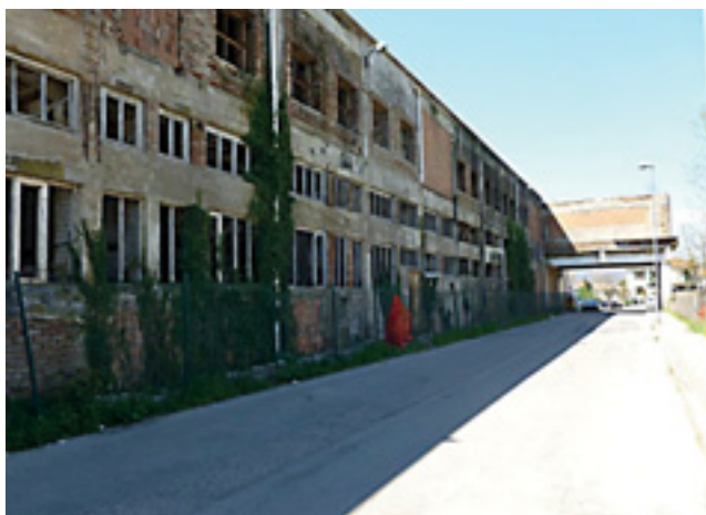
La parte in stato di degrado del vecchio stabilimento Buitoni, acquistata dalla Provincia di Arezzo
