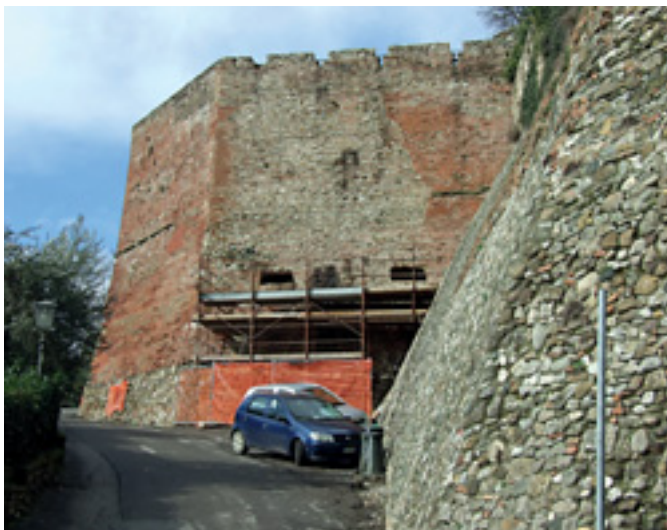
Il cantiere allestito al Bastione del Vicario con le bocche di fuoco spuntate fuori durante i lavori
